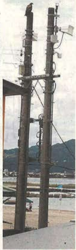
③海辺のみまもりシステムの運用が始まった若狭和田ビーチ電柱(左端)に取り付けたカメラで離岸流の発生を検知する
